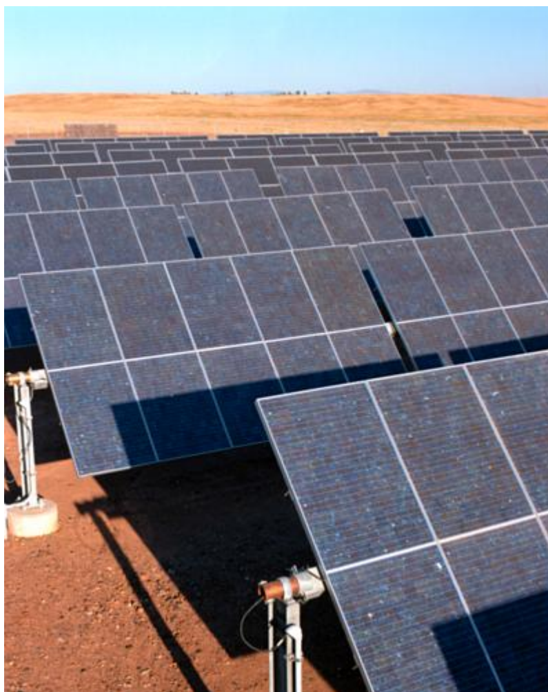
Figure 20 : Champ de panneaux solaires Source : Technology Environment Data Leap 2000.
